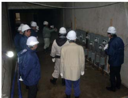
鋼板接着工法
